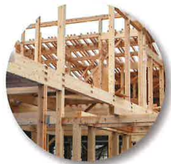
構造躯体状況 (柱・梁)
