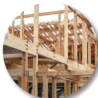
構造躯体状況 (柱・梁)
